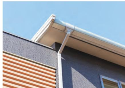
雨樋・縦樋（屋根から垂直に伸びている樋）を地上から目視点検し、亀裂やずれ、歪みがないかチェックします。
